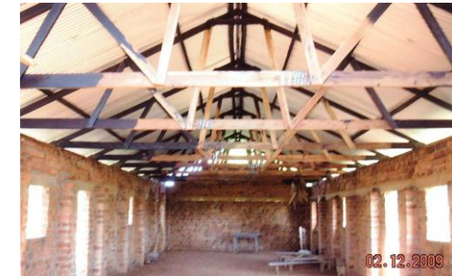
CAPPELLA IN COSTRUZIONE
